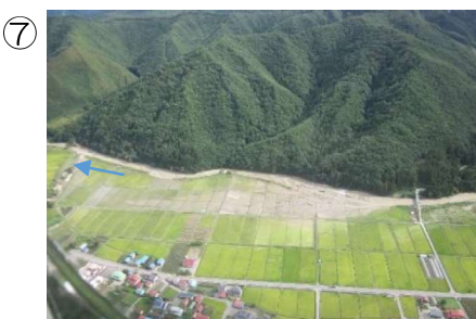
⑦ 金井沢地内 背後地への土砂流入状況（空撮）
