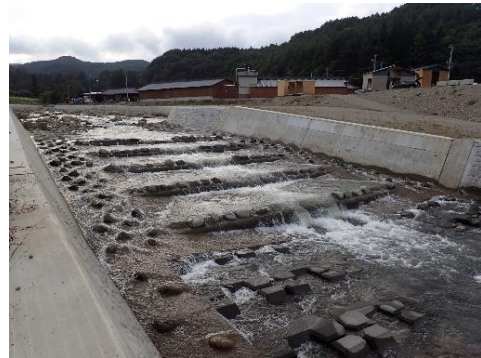
(桧沢川4号床止完了)
