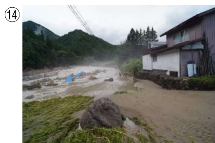
⑭ 十本木地内 家屋の浸食被害
