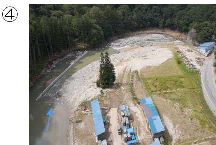
④ 館岩川の越水による土砂流入状況 (ドローン撮影)
