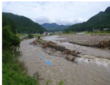
屈曲部で越水し護岸の背後を水が流れている
