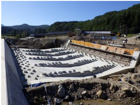
(桧沢川4号床止施工時)
