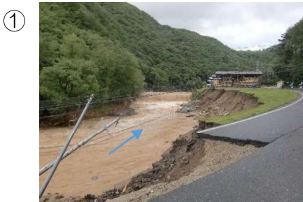
① 侵食により国道 352 号が崩落
