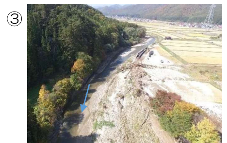
③ 塩江地内 背後地への土砂流入状況（ドローン撮影）
