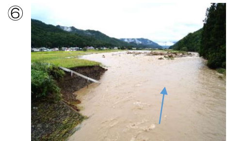
⑥ 金井沢地内 越水による破堤及び背後地の浸水状況
