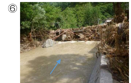
⑥ 新田橋上流側から見た流木の状況
