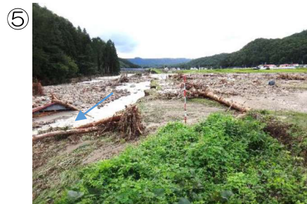
⑤ 金井沢地内 越水による破堤及び背後地の浸水痕跡
