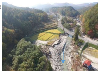
⑮ 針生地内 下針生橋から下流側の浸食状況
