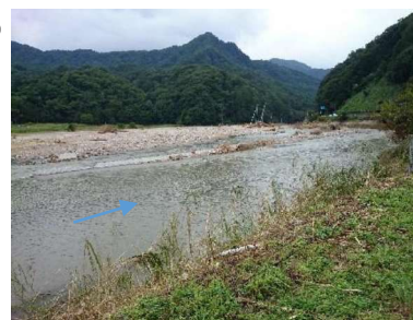
熨斗戸地内の土砂流入状況
