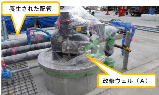
(写真1) 改修ウエル(A)の状況 設備が更新されており、ビニール養生されていた。 配管もビニール養生されていた。
