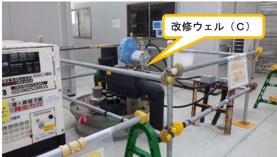
(写真3-2) 改修ウエル (C) の状況
