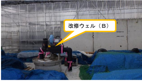
(写真3-1) 改修ウエル (B) の状況
