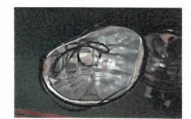
地震により落下した大型照明器具 富岡高校
