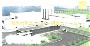
福島水素エネルギー研究フィールド
