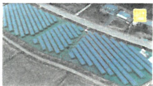
大熊町ふるさと再興メガソーラー発電所
