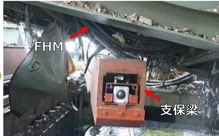
II-a. 支保梁挿入中 (撮影日: 2020.10.20)
