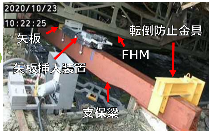
III. 矢板・転倒防止金具設置 (撮影日: 2020.10.23)
