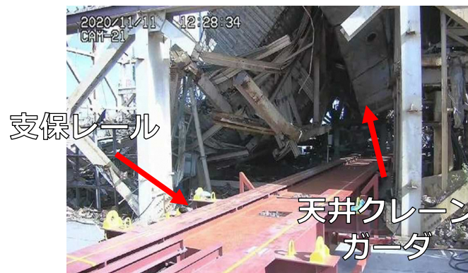
I. 支保レール設置完了 (撮影日: 2020.11.11)
