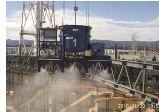
飛散防止剤散布状況
