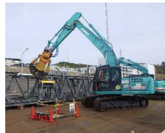
上部解体時の小割解体状況 撮影：2017.4
