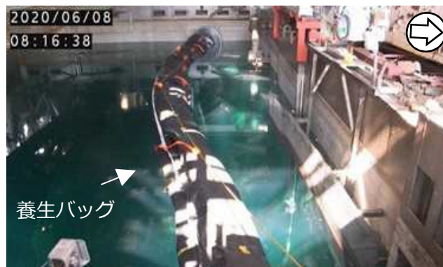
養生バッグ投入（撮影日：2020.6.8）
