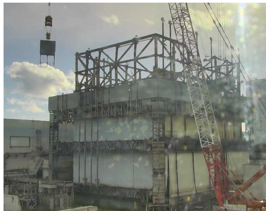
防風フェンス取り外し状況 (2020年12月19日時点)
