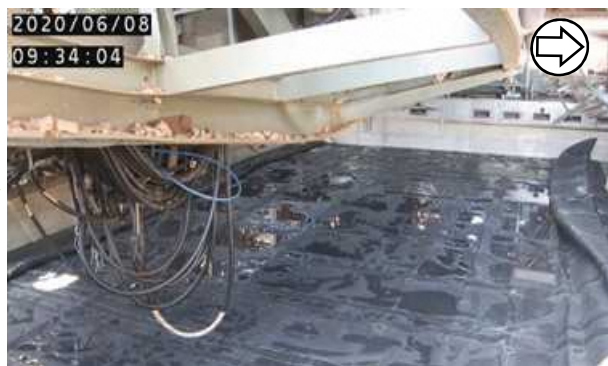
養生バッグ展張（撮影日：2020.6.8）
