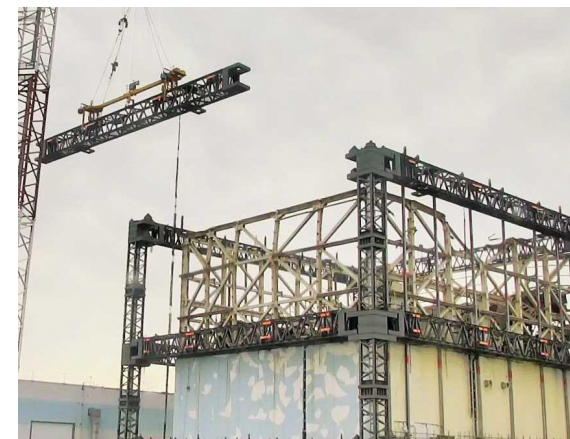
上部解体時の梁取り外し状況 撮影：2017.7
