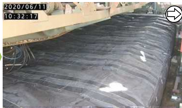
エアモルタル充填（撮影日：2020.6.11）
