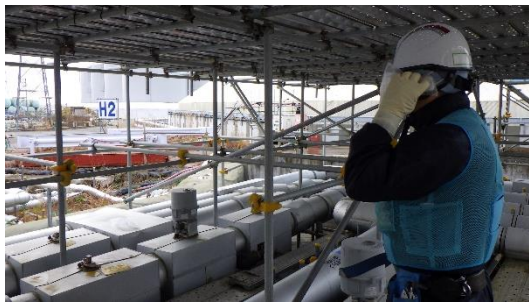
(写真3) 免震重要棟集中監視室に異常のない ことを報告
