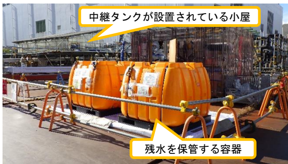
(写真 2 - 1) 中継タンク内の残水移送に向けた準備状況①
