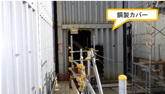
(写真 1 - 2) サブドレンピット No. 40 設置箇所
