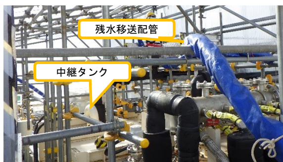
(写真 2 - 2) 中継タンク内の残水移送に向けた 準備状況②
