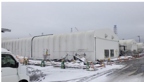
(写真1) 淡水化装置 (RO1) が設置されているジャバラハウスの外観
