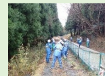
用排水路の維持管理作業
