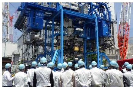
〈廃炉安全監視協議会立入調査〉 (1/2号機排気筒切断装置)
