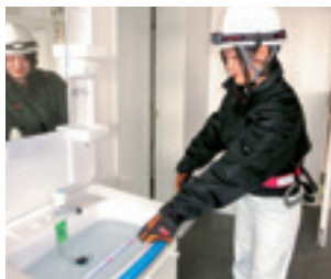
▲現場での仕上がり確認
