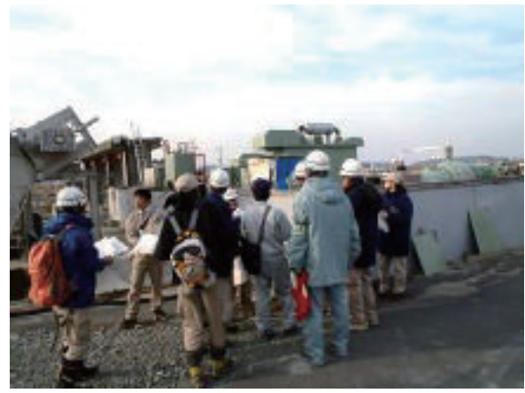
写真-4 査定状況(相双管内の排水機場)
