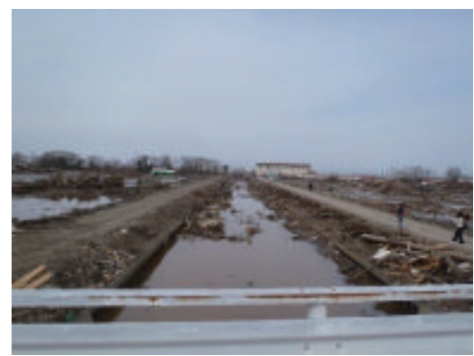
写真-6 H23.4.7同左の湛水解消状況
