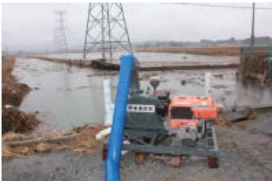
写真-1 H23.3.21駒ヶ嶺地区の応急対応状況
