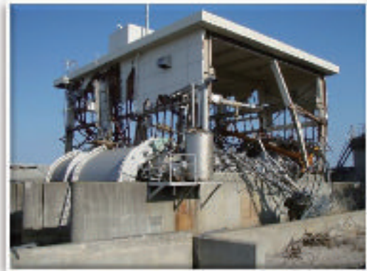
棚塩排水機場(浪江町)
