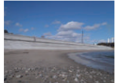
写真-3 浅見川地区復旧状況
