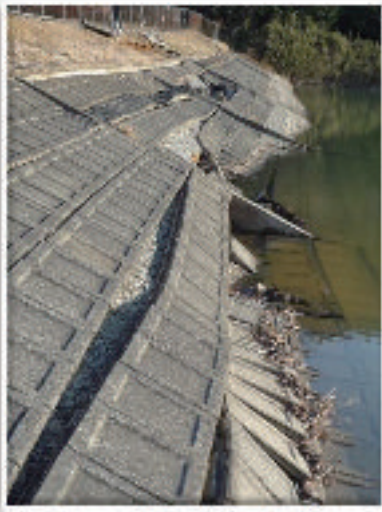
波除工の崩落（四郎平ため池）新地町
