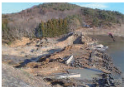
写真-1 本堤(左岸から右岸)
