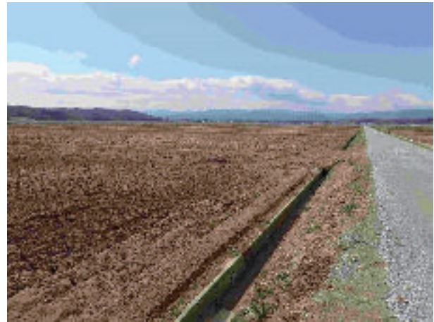
写真-2 磯部地区(相馬市)復旧後
