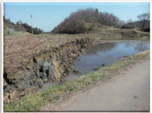
農道の崩落(三春町過足)
