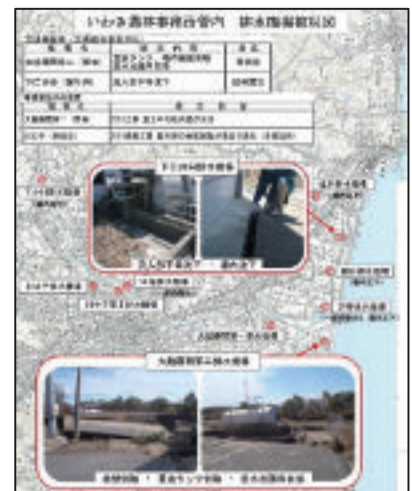
図-1 排水機場の被災状況 (当時の資料を一部修正)
