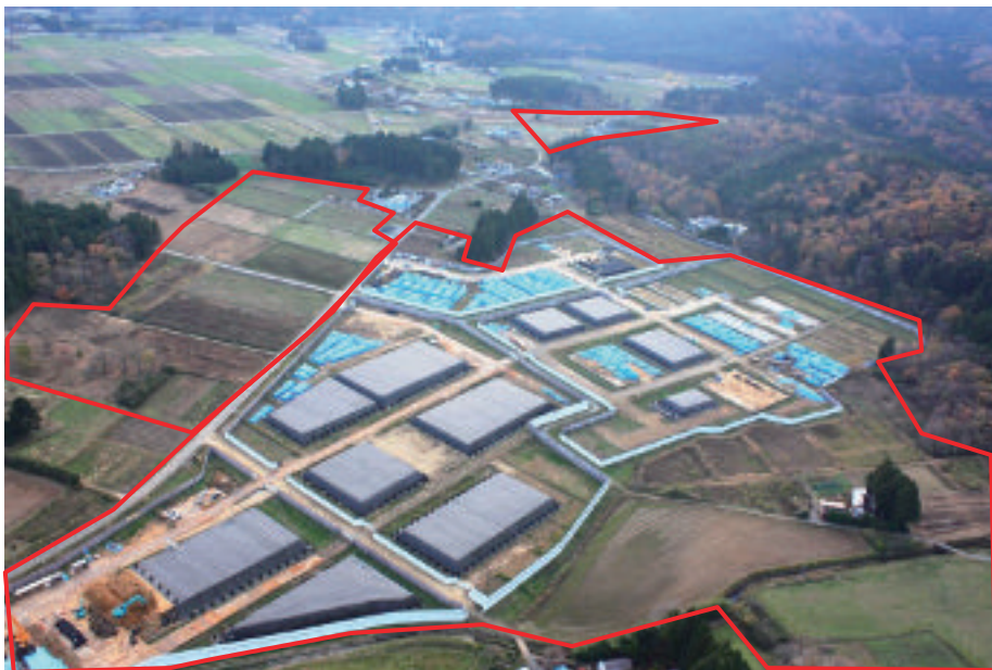
写真-1 ほ場整備地区内仮置き場(事業採択地区)
