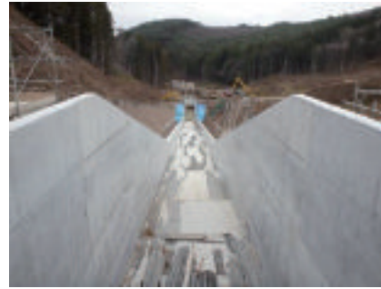
写真-7 洪水吐上流より(平成27年12月)
