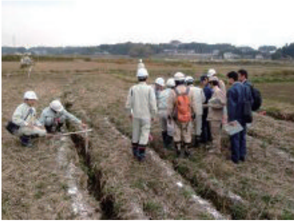
写真-1 査定状況(相双管内の農地)
