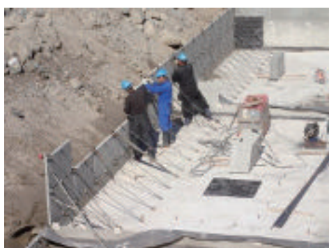
写真-6 山田浜地区における残存型枠実施状況
