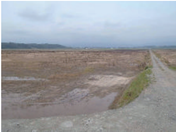
写真-1 磯部地区(相馬市)施工前
