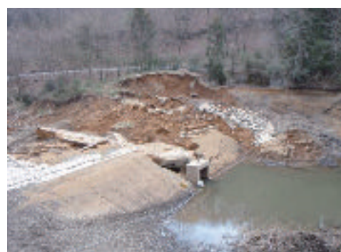
写真-2 中池決壊状況(福島県須賀川市)
