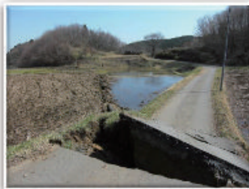
4月11日、断層により東日本大震災の余震が発生し、 農地や農道が沈下した。(いわき市田人町)
