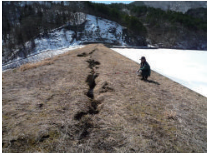
写真-1 地震によるため池の被災
