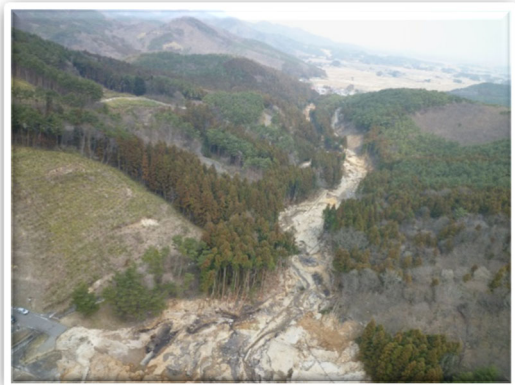
流出した貯留水と土砂の痕跡
