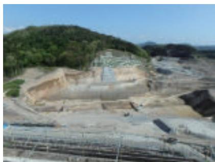
写真-4 本堤掘削左岸より(平成27年4月)
