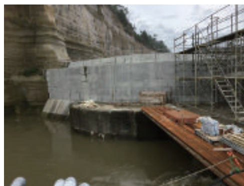
写真-5 海口閘門廻りの堤防嵩上げ区間
