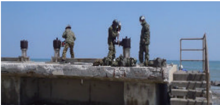
写真-3 大型スパナでの樋門操作状況
