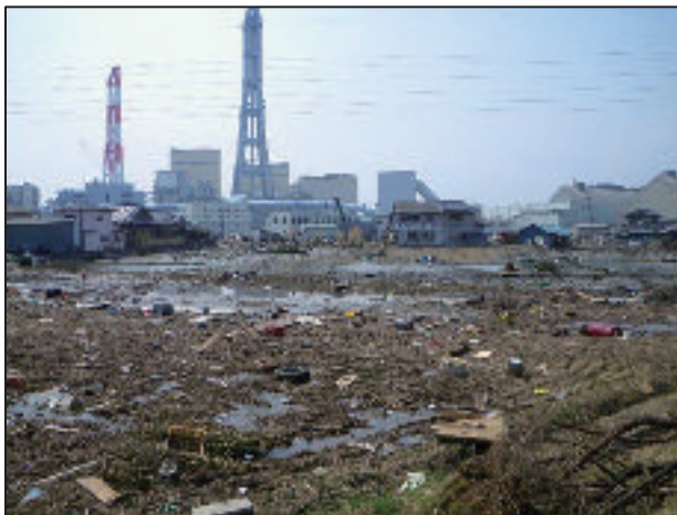
写真-1 被災直後の状況
