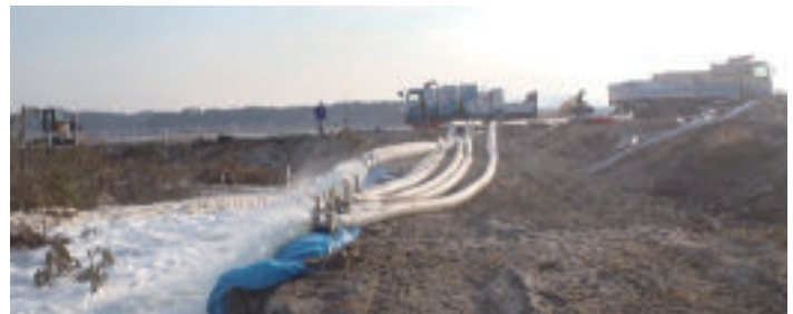
写真-6 ポンプ車による排水開始
