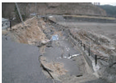
写真-2 副堤(左岸から右岸)
