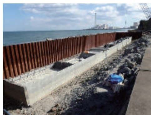
写真-7 残存型枠施工状況
