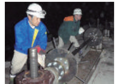
写真-5 夜間の樋門開閉操作
