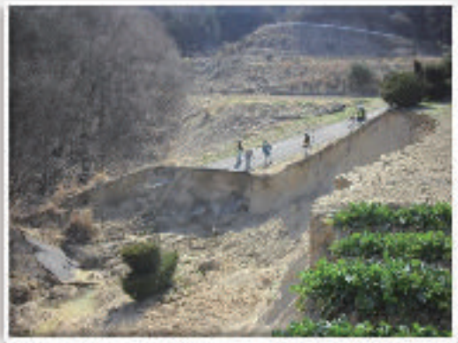
農道の崩落(三春町過足)
