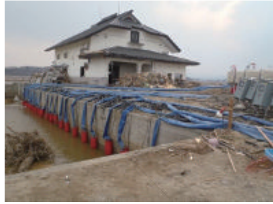
写真-4 H23.3.30同左の湛水解消状況(水中ポンプ)
