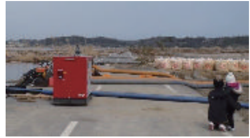
写真-2 ポンプ排水状況
