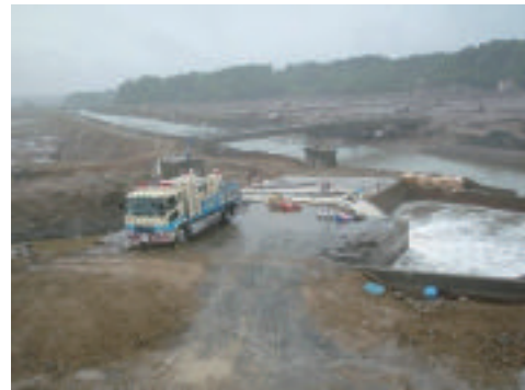
写真-8 H23.5.29同左の応急対応状況(国土交通省ポンプ)
