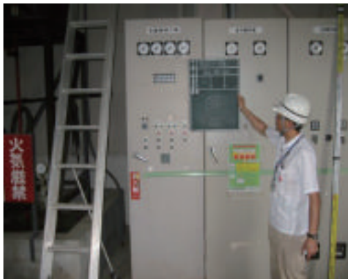
写真-1 津波による湛水深の明示(駒ヶ嶺地区)
