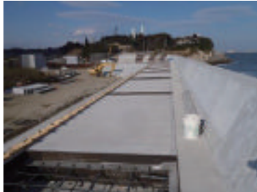
写真-2 浅見川地区復旧状況
