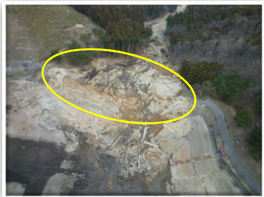
本堤(黄色丸枠内)破堤後の空撮写真
