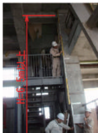
写真-4 津波による湛水深の明示(古磯部第二地区)
