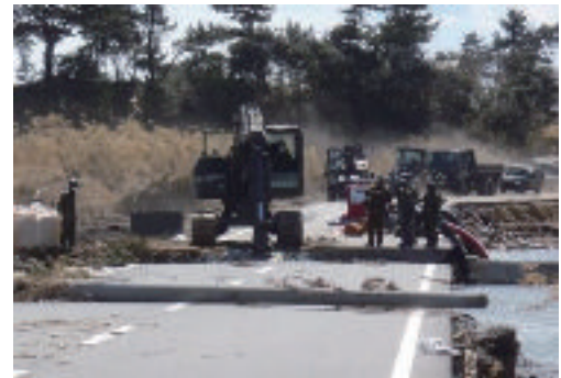
写真-4 啓開作業状況
