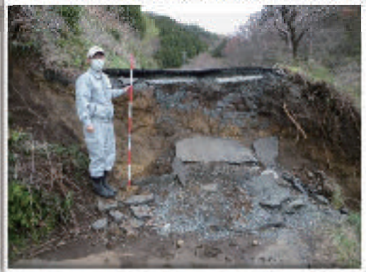
4月11日、断層により東日本大震災の余震が発生し、 農地や農道が沈下した。(いわき市田人町)
