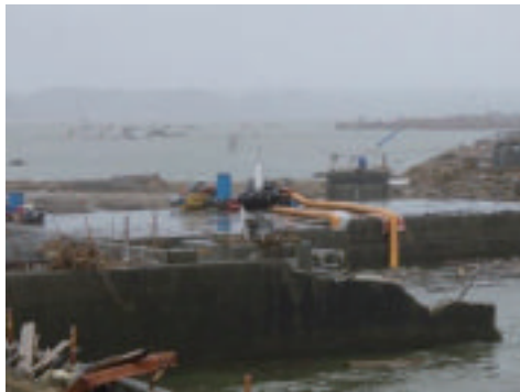
写真-7 H23.4.19 井田川地区の応急対応状況(農水ポンプ)
