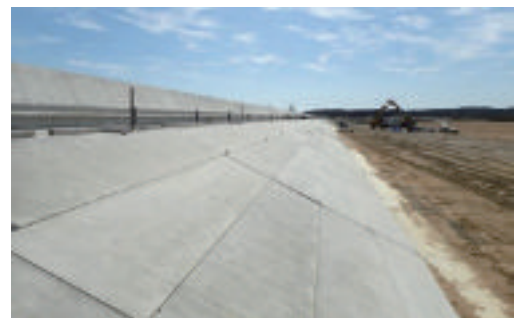
写真-4 北海道における コンクリート被覆ブロック設置状況
