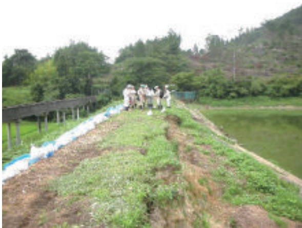
写真-3 査定状況(県北管内のため池)
