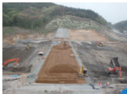
写真-5 本堤盛立左岸より(平成28年4月)
