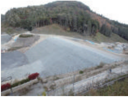
写真-6 副堤盛立完了後(平成27年10月)
