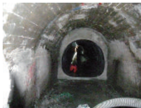
写真-1 藤沼湖取水トンネル(福島県須賀川市)
