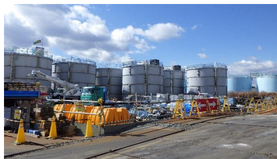
(写真1-2) タンク解体作業の状況 (北東側から撮影) (令和3年2月10日撮影)
