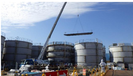
(写真1-1) タンク解体作業の状況 (北東側から撮影) (令和2年11月18日撮影)
