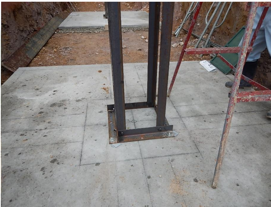
pic.24 平成30年6月末の状況（基礎アンカー設置工事中）
