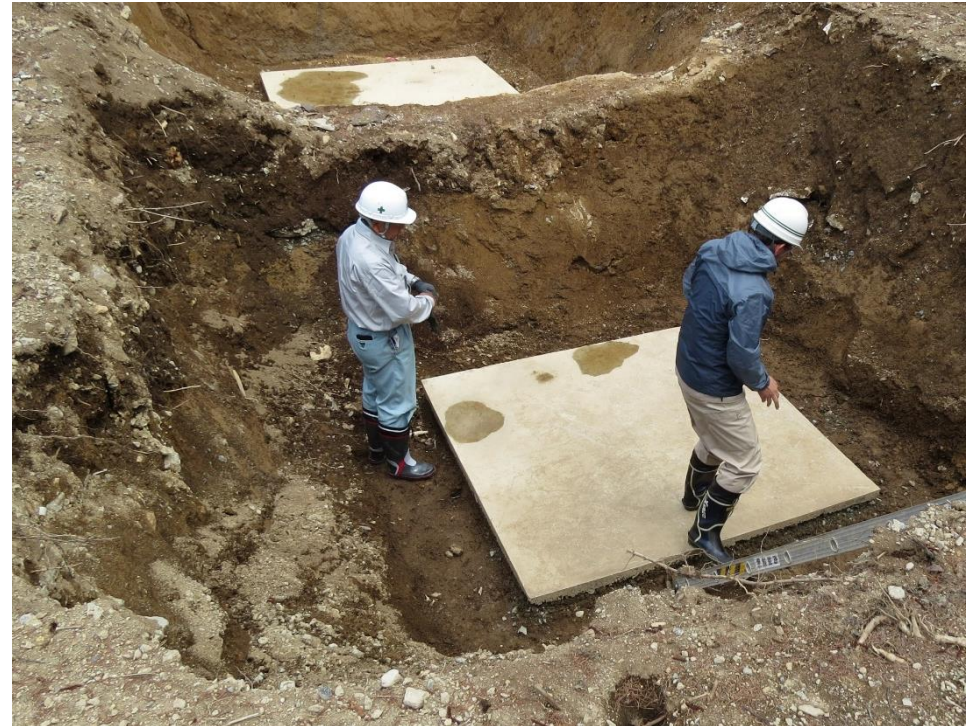
pic.23 平成30年5月末の状況 (均しコンクリート工事中)
