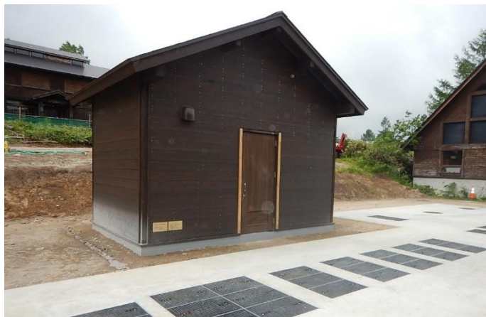
pic.9 第2 公衆便所浄化槽改修 (H 2 9年完成)
