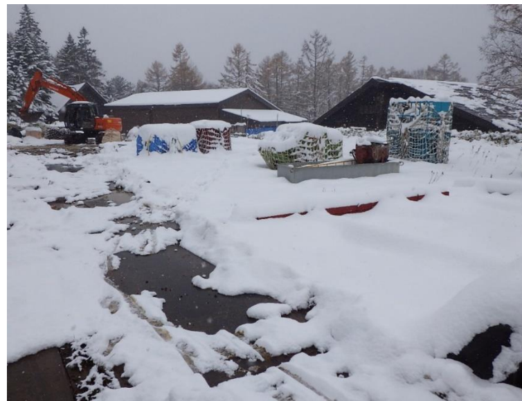
pic.16 10月中旬の現場の状況
