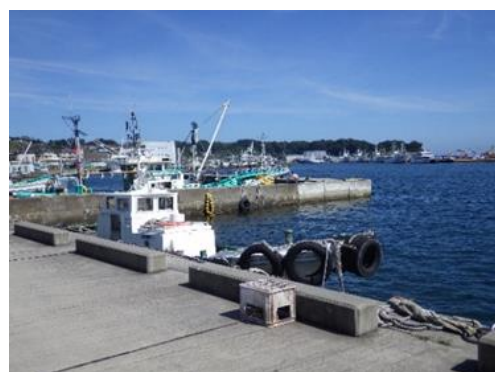
調査した小名浜港岸壁
