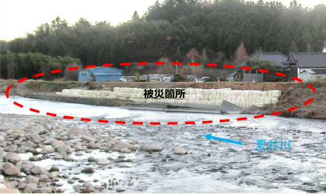
②小川町上小川字間門地内 【施工前】
