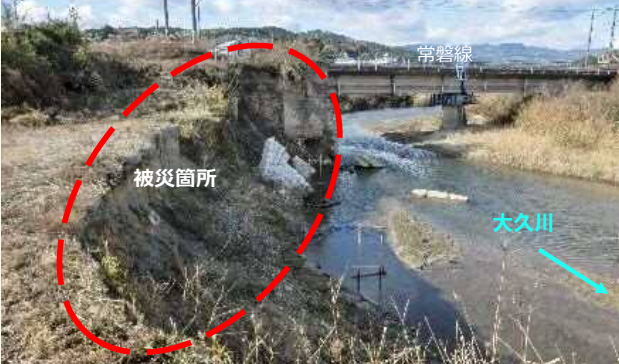
②久之浜町字後三松地内 【施工前】
