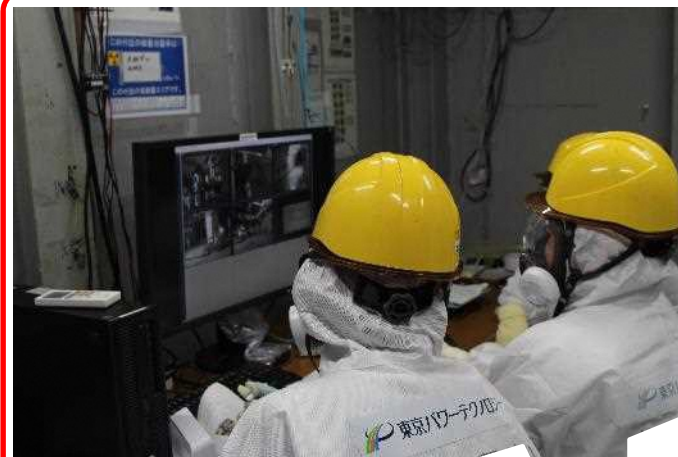
現場本部 (2号原子炉建屋西側ヤード)
