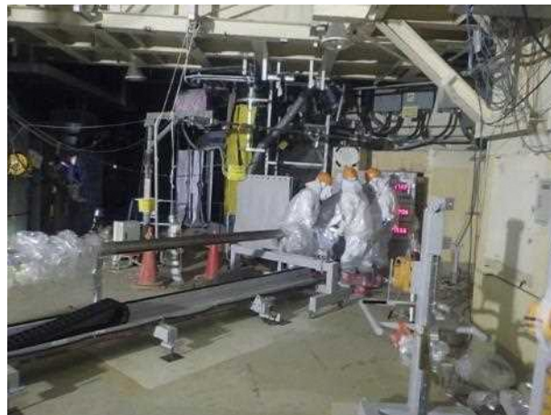
X-6ペネ前での調査装置設置作業
