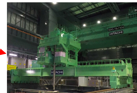
天井クレーン (地震前撮影)
