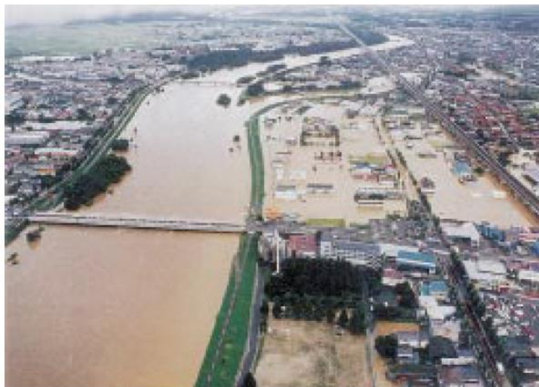
写真 4 笹原川合流点左岸側の氾濫状況 (福島工事事務所提供)
