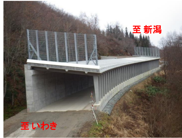
スノーシェッド工事状況
