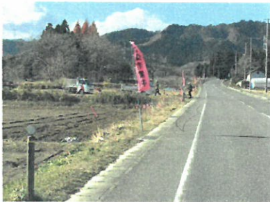
除染作業 (南相馬市小高区)
