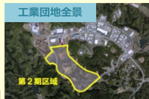
工業団地全景
