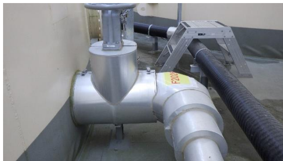
(写真 3) 配管の状況
