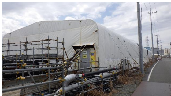
(写真1-1) 既設淡水化装置 (RO3) の外観 北東側から撮影
