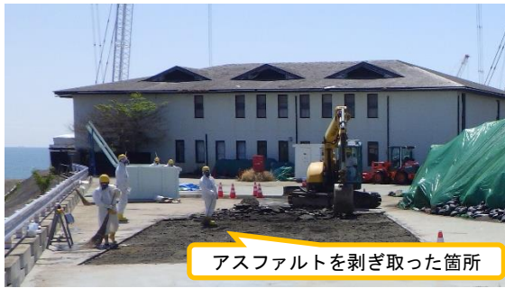
(写真1) アスファルト剥ぎ取り作業の状況
