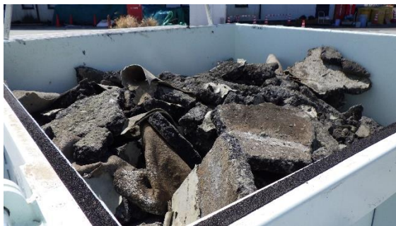
(写真2) コンテナに収納された剥ぎ取られた アスファルト
