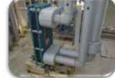
廃熱回収用熱交換器
