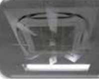
老朽空調機の更新
