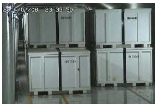
固体廃棄物貯蔵庫
