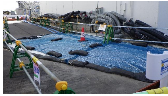
(写真1-2) サイトバンカ建屋北西側陥没箇所 (仮復旧作業完了箇所) (今回撮影：令和3年5月10日)
