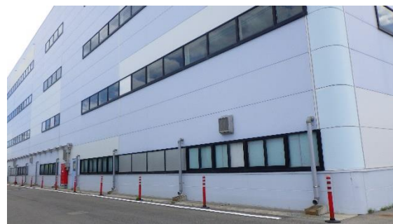
(写真4-2) 大型機器メンテナンス建屋（北側） 周囲の状況 (今回撮影：令和3年5月10日)
