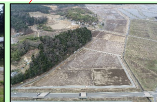
整地工完了状況
