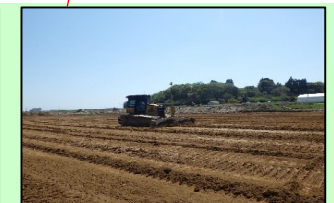
整地工事状況
