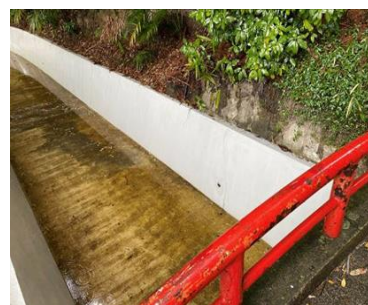
(彩画前の小川江筋用水路の状況)
