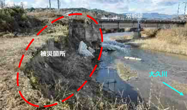
②久之浜町字後三松地内 【施工前】
