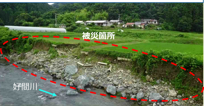
②好間町北好間字寺入地内 【施工前】
