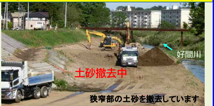
狭窄部土砂撤去中 (30%の進捗)
