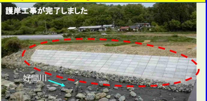
護岸工事 (100%完了)
