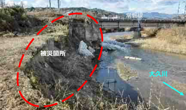
②久之浜町字後三松地内 【施工前】
