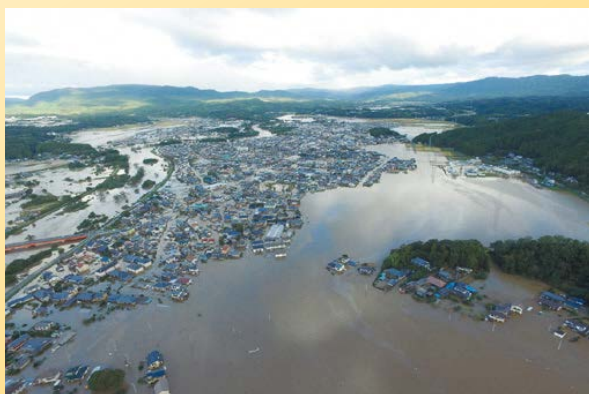
令和元年東日本台風による被害 夏井川（いわき市）
