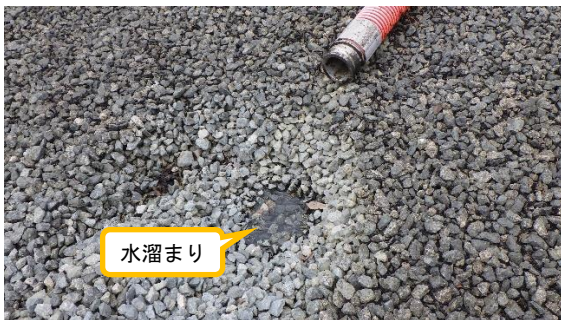
(写真 3) 雨水散水地点 (大熊町側) の地表面 の状況
