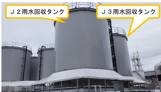
(写真1-1) J 2、J 3 雨水回収タンク (北西側から撮影)
