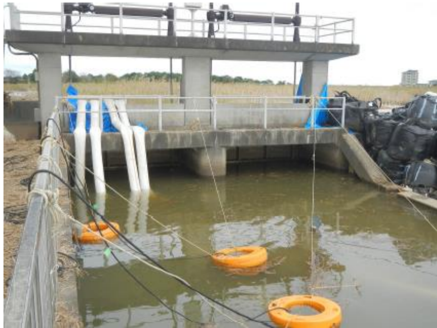
和田地区 排水ポンプ設置（相馬市）
