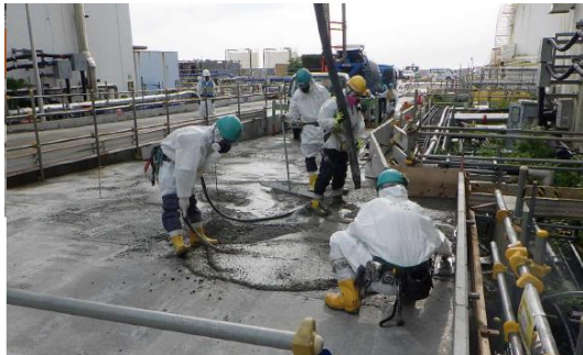
<コンクリート打設>
