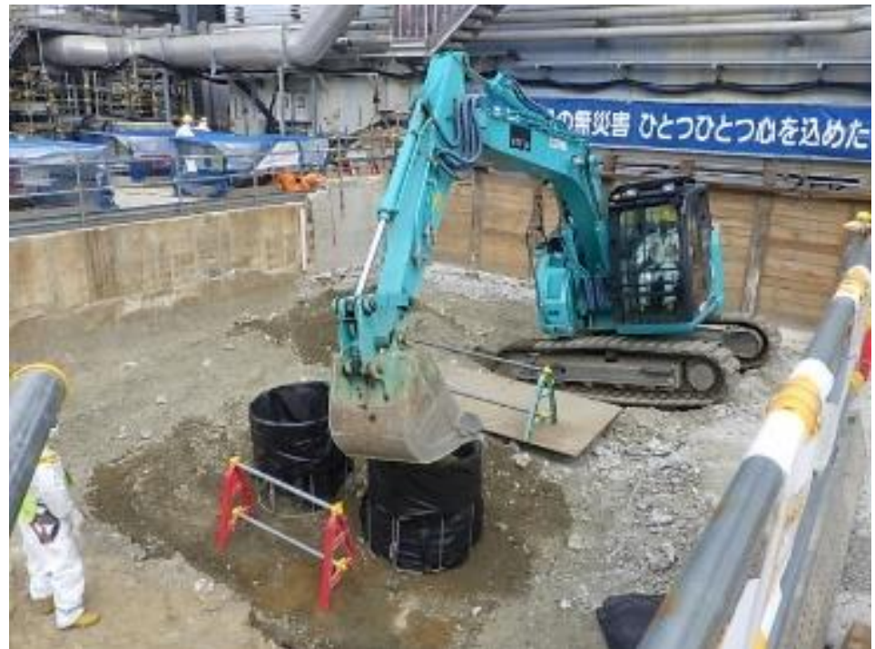
<掘削土の詰め込み作業の状況>
