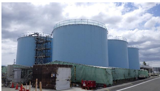
(写真1-1) H8北タンクエリアの概観 (北西側から撮影)
