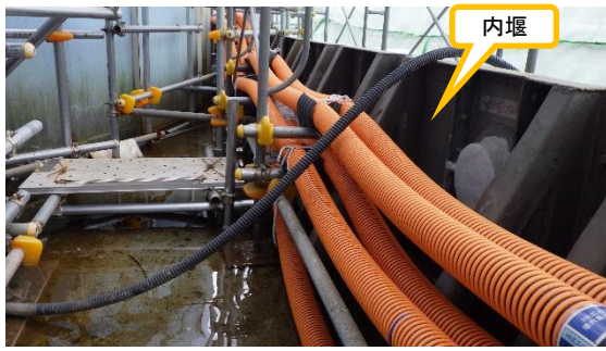
(写真4-2) H8南タンクエリア内堰内の移送配管(耐圧ホース)敷設状況
