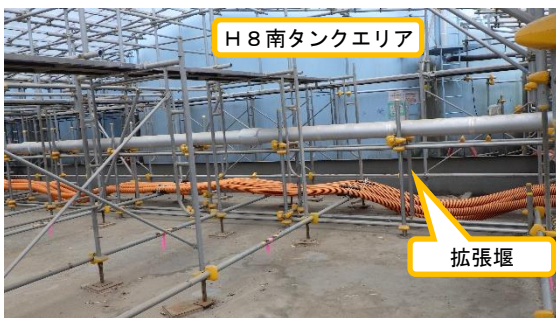
(写真 4 - 1) 拡張堰内の移送配管 (耐圧ホース) 敷設状況
