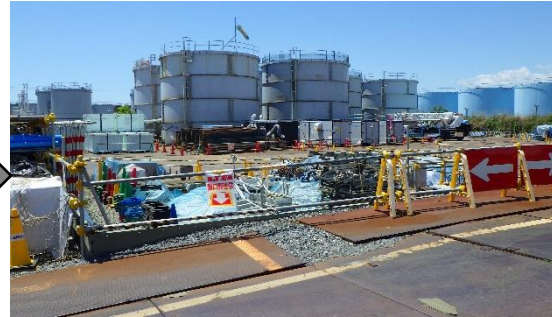
(写真1-2) 今回の状況 (令和3年5月31日撮影)
