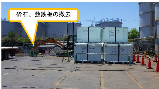
(写真3-1) 重機等足場の撤去状況
