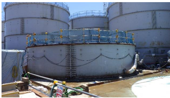
(写真1-3) 解体中のタンクの状況
