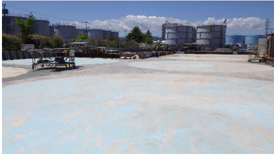
(写真3-2) 撤去後の状況 (東側から西側を撮影)
