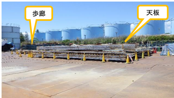
(写真2) 天板及び歩廊の仮置き状況
