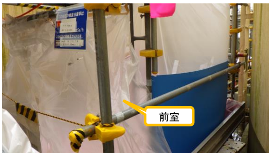
(写真1-2) K1南タンクエリア 前室の設置状況(2)
