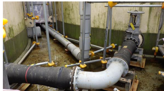
(写真2-2) K1南タンクエリア 交換前の連結管・連結弁
