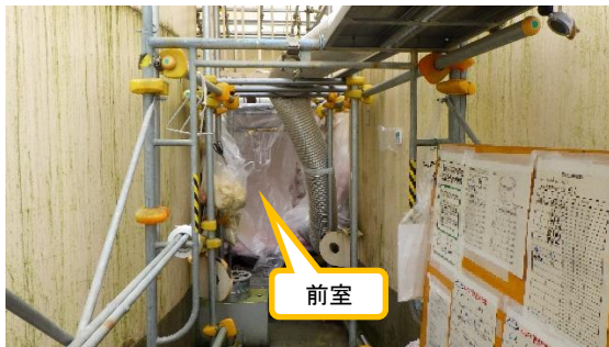
(写真1-1) K1南タンクエリア 前室の設置状況(1)
