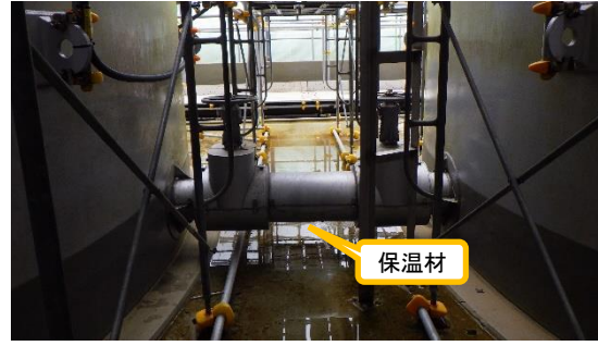
(写真3-2) K2タンクエリア 交換されていない連結管・連結弁 (洗浄作業等対象とならないタンク 同士のため)
