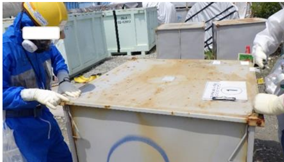
(写真1-4) 腐食孔のテープ補修状況
