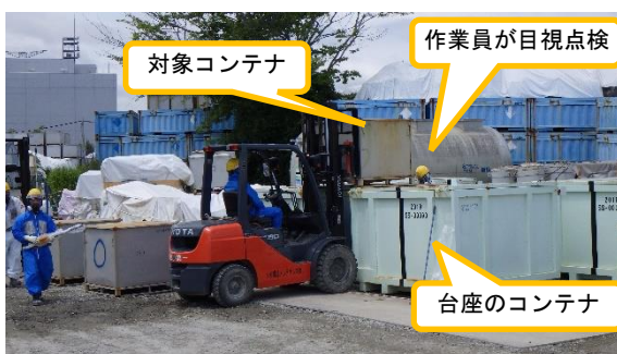
(写真1-2) コンテナ底部の目視点検状況 (台座のコンテナ2基の上に対象コンテナを載せ底部を目視点検)
