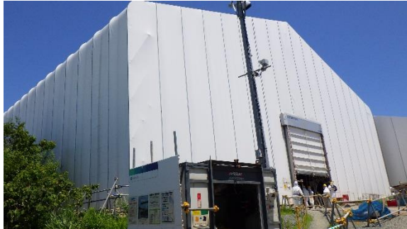
(写真1-1) 一時保管エリアA1の外観 (エリア南西側から撮影)
