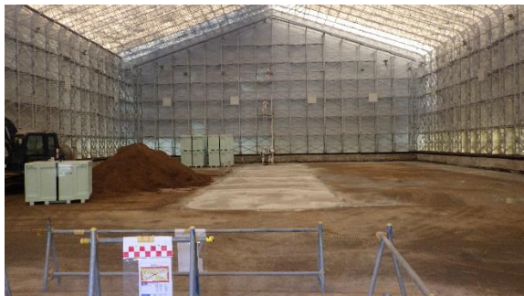
(写真1-2) 一時保管エリアA1のテント内部の 状況
