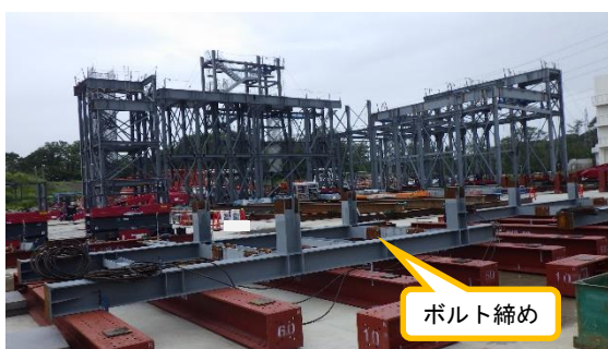
(写真2) 組立作業の状況
