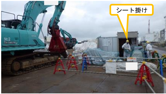
(写真5) 小割解体ヤードでの作業状況
