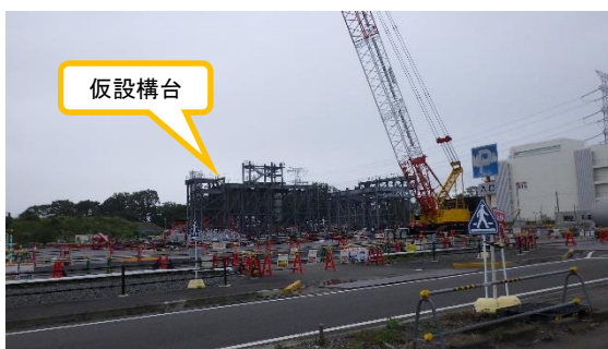
(写真1) 西門前ヤードの状況
