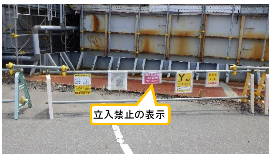
(写真1-2) 一時保管エリアNの状況②
