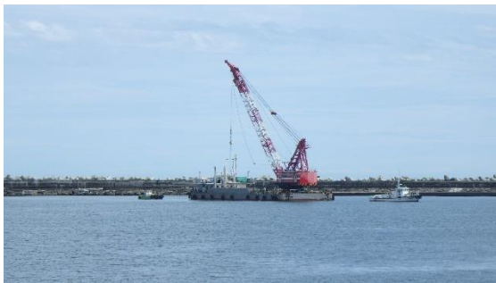
(写真2-1) 入港した起重機船の状況 (物揚場から撮影)
