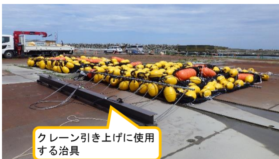
(写真2-2) 交換用の魚類移動防止網の状況 (物揚場から撮影)
