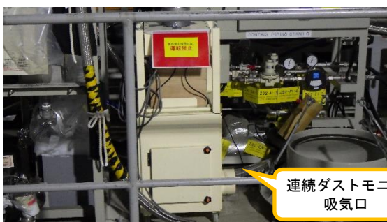
(写真1-2) 代替フィルタの設置状況② (南側から撮影)
