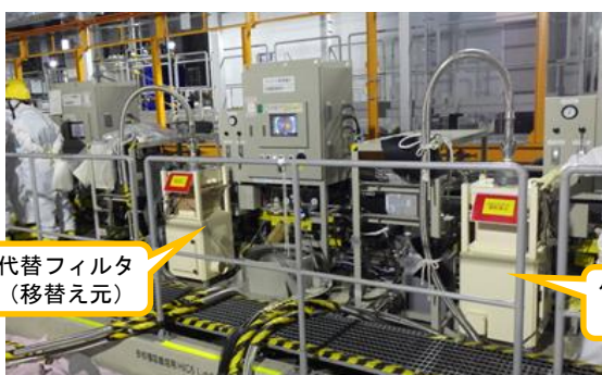
(写真1-1) H I C排気ライン代替フィルタの設置状況① (南側から撮影)
