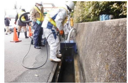
〔写真〕技術実証の様子
