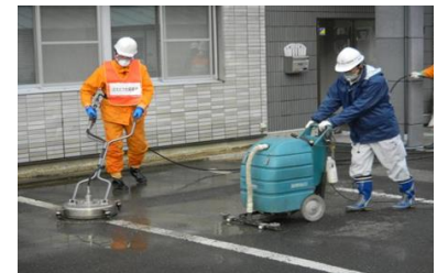
〔写真〕技術実証の様子
