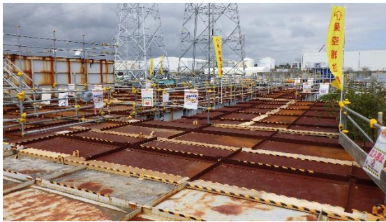
(写真2-1) ノッチタンク上部の状況
