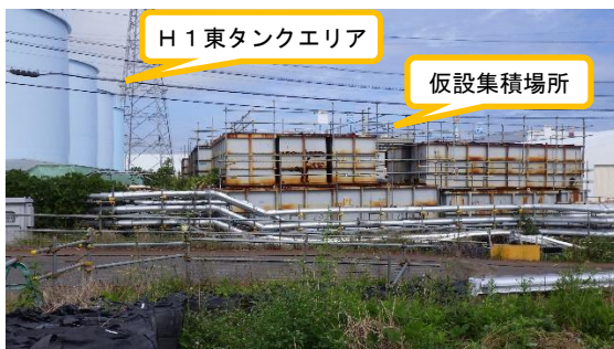
(写真1-1) H1東タンクエリア東側の 仮設集積場所の外観 (南側から撮影)
