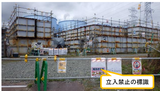
(写真1-2) 仮設集積場所入口の状況 (南東側から撮影)
