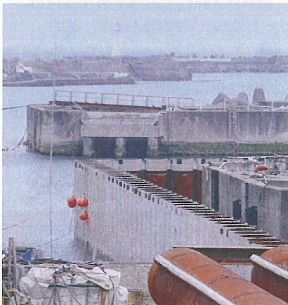
1～4号機取水口北側の状況
