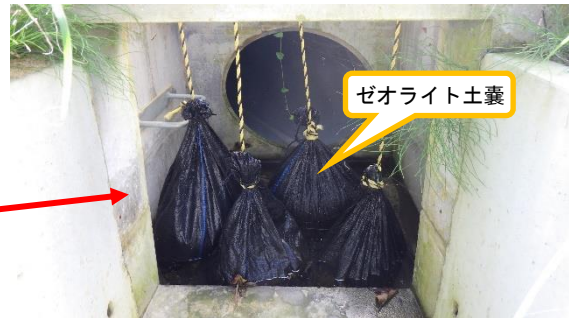
(写真5-4) 南側排水溝排水口の状況② （北側から撮影）
