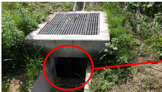
(写真5-3) 南側排水溝排水口の状況① （北側から撮影）
