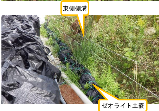
(写真 5 - 1) ノッチタンク 東側側溝手前の状況 (南側から撮影)
