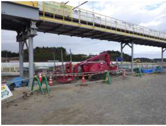
ベルトコンベアによる除去土壌の運搬状況 飛散防止対策として、ベルトコンベアは鉄板で覆われていた。
